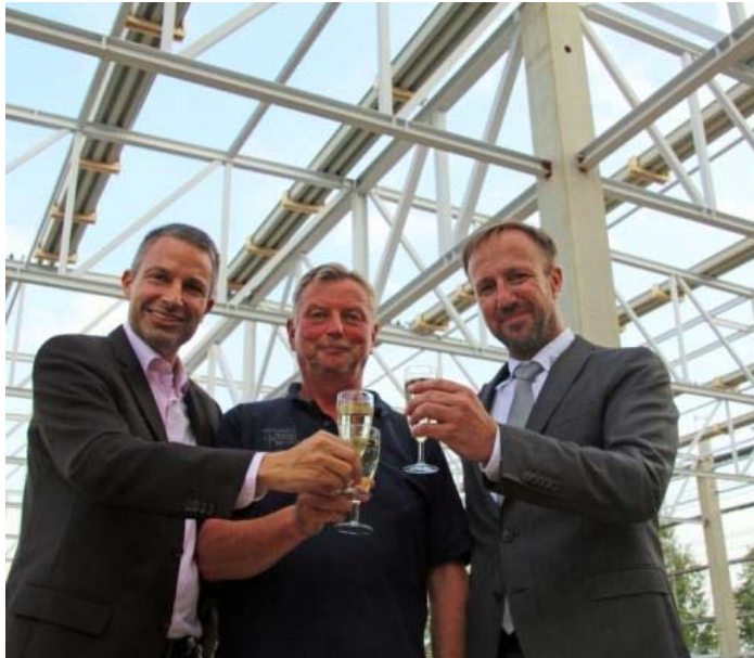
Die Geschäftsführer Stephan C. Kratzer (l.) und Marcus Adelman (r.) stoßen gemeinsam mit Stahlbauer Uwe Rücker zum Richtfest an. Foto: Wieland Josch Foto: Wieland Josch
